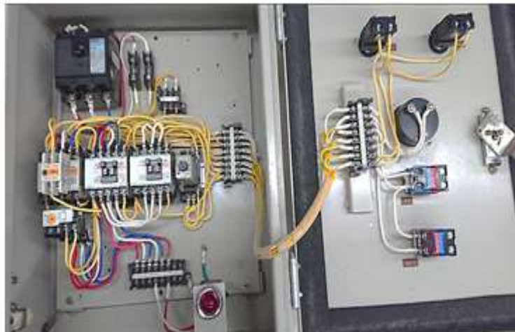
盤内図(補助接点ユニットあり)
