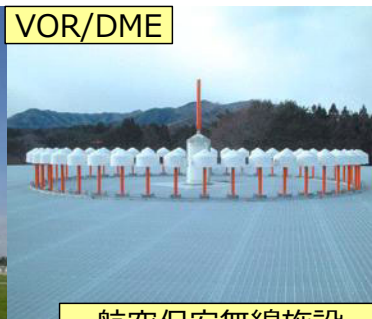
航空保安無線施設
