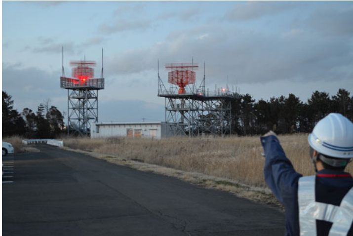
灯火巡回点検の様子
