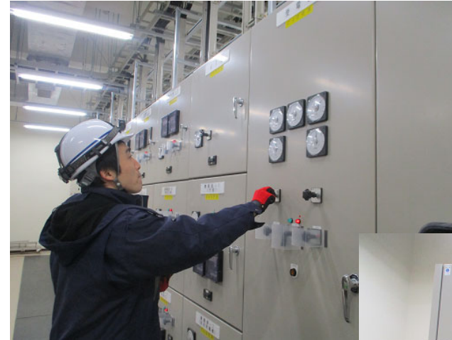
電気施設巡回点検の様子
