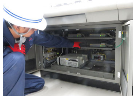
電力監視制御装置 通常点検
