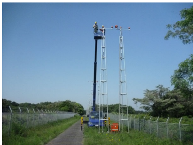
状態点検 (場所によっては高所作業車 や船舶を使用)
