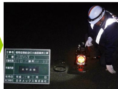
水平点検・調整・絶縁測定 (水準器等により水平、向き、 仰角を点検し調整)
