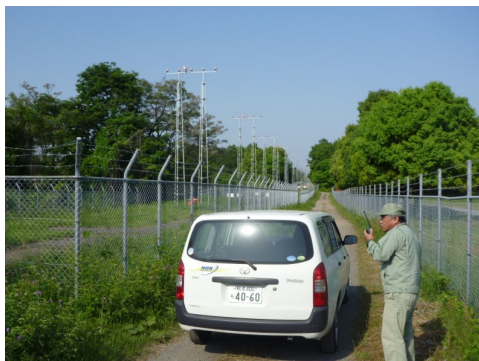
灯火巡回点検（ライトチェック）の様子
