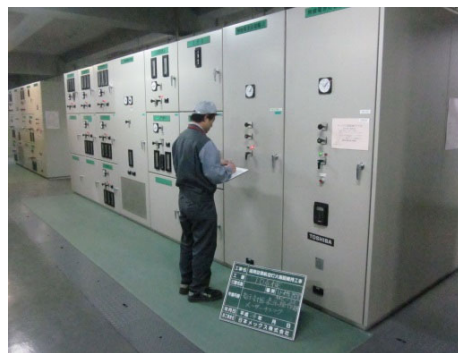
電気施設巡回点検の様子
