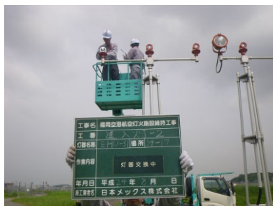
上部灯体交換 (場所によっては高所作業車 や船舶を使用)
