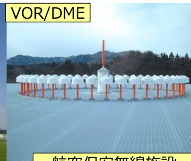
航空保安無線施設
