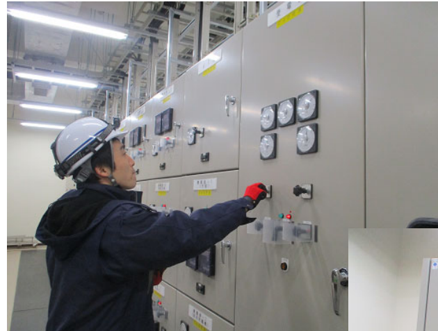
電気施設巡回点検の様子
