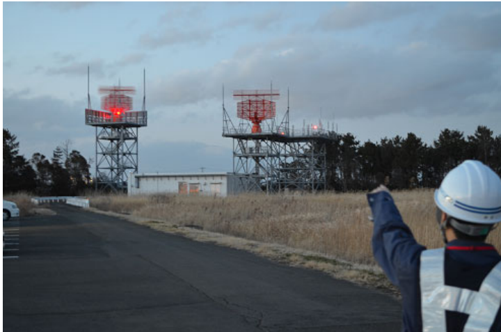
灯火巡回点検の様子
