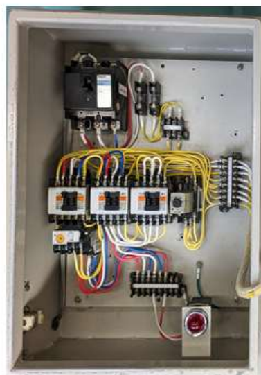
盤内図(補助接点ユニットあり)
