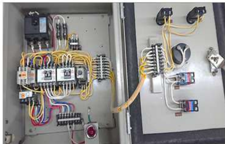
盤内図(補助接点ユニットあり)
